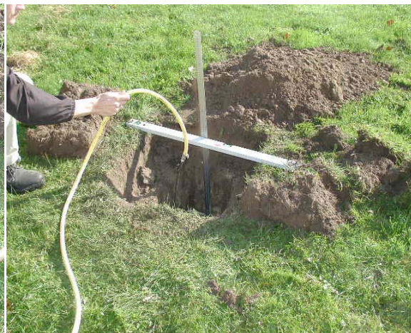
Vandmætning af jorden kan begynde. Der fyldes min. 0,2 m vand over gruslaget.
